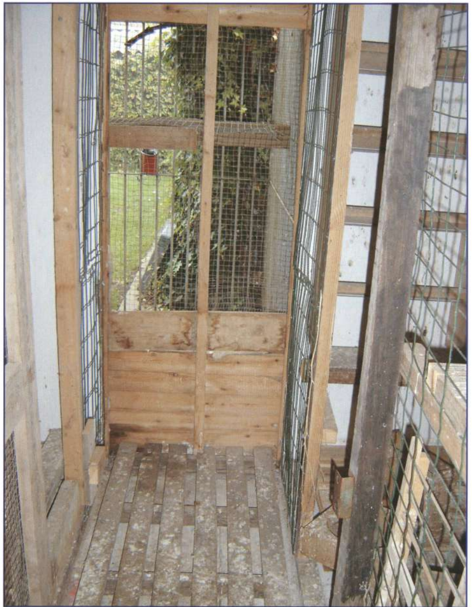
Een vochtig en muffig tuinhokje werd droog en luchtig door met de slijpschijf de rug van de gang tussen de twee afdelingen weg te slijpen en te vervangen door gaas.
